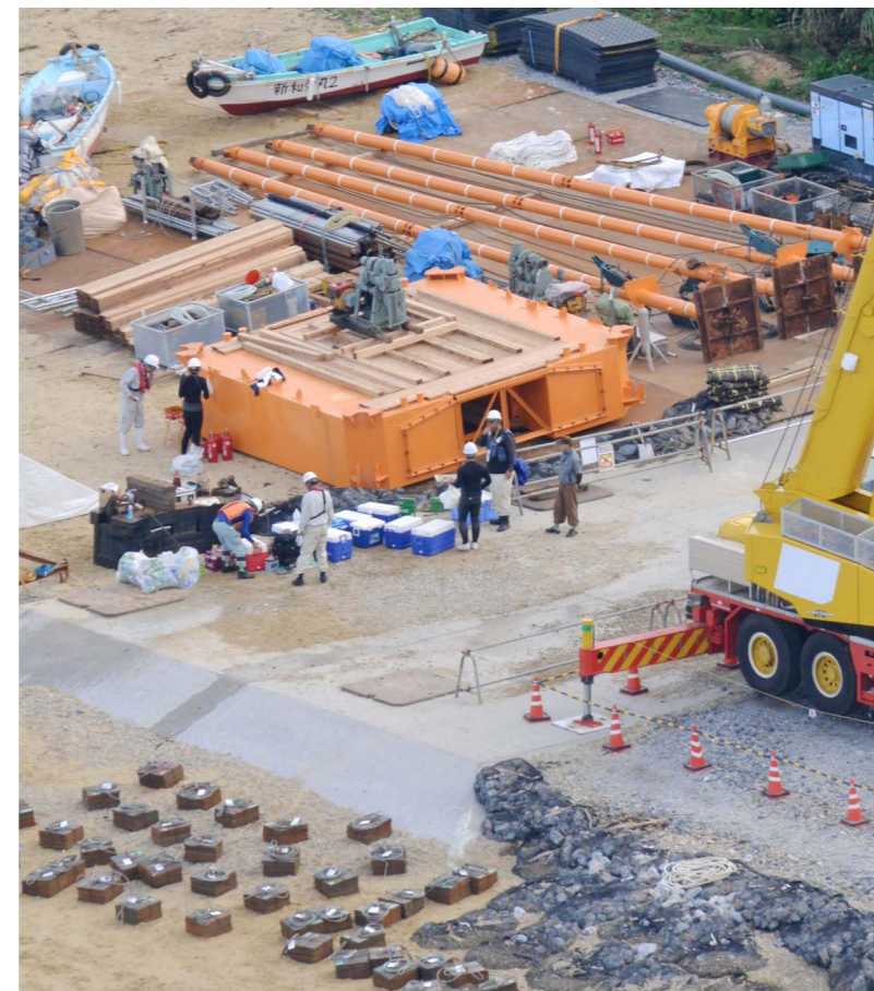
辺野古沖での調査開始に向け、オレンジ色の足場の台に設置されたボーリング機=16日午後5時ごろ (毎日新聞ヘリから花城太撮影)
