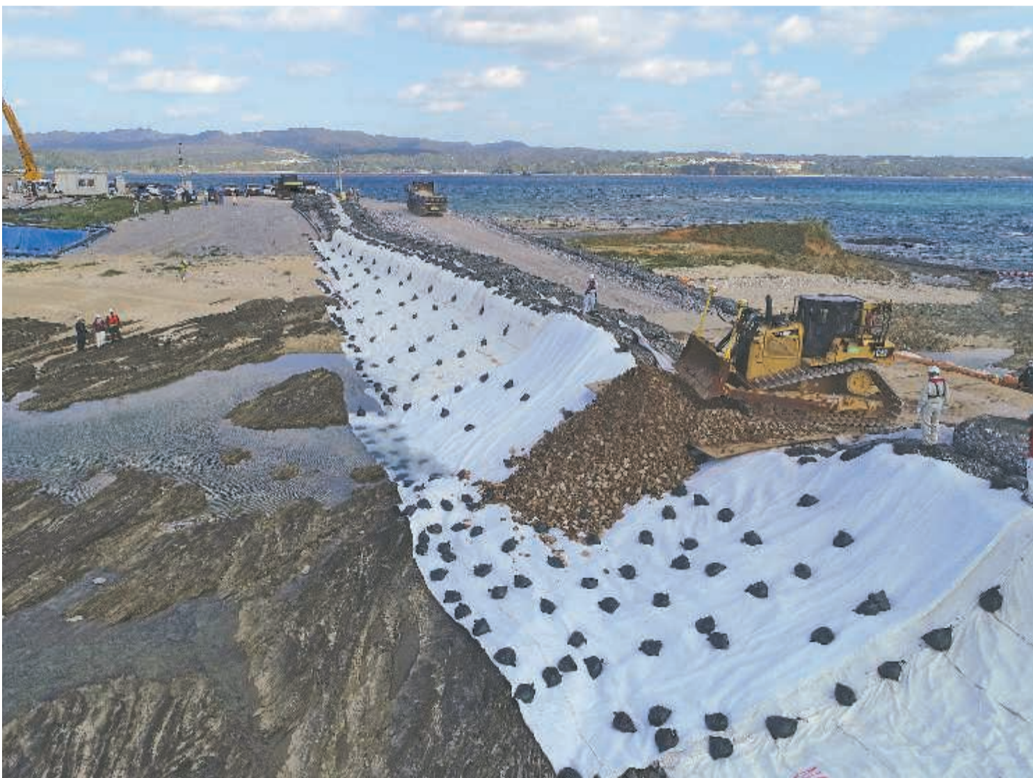
米軍キャンプ・シュワブ辺野古崎の埋め立て区域に投入される土砂 ＝14日午前11時すぎ、名護市辺野古(小型無人機で撮影)
