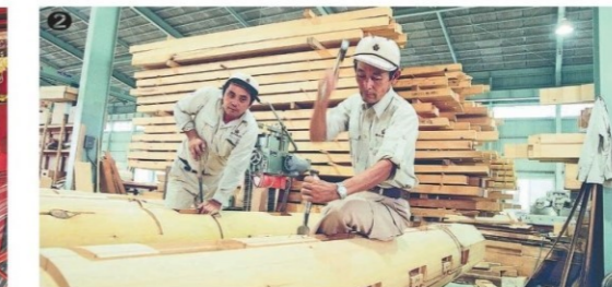
②正殿の復元工事で、くぎを使わずに手作業で柱などを組み立てていく職人=1990年9月 ③首里城の南殿などに使われた屋根瓦には、1万円を出資した人たちの名前が記されている。首里城公園友の会が、公園完成後の運営を支える目的で出資者を募った=92年1月
