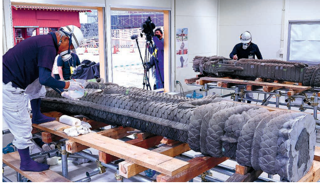
火災で損傷した部分に樹脂を注入するなど、文化財修復士によって補修が施される大龍柱
