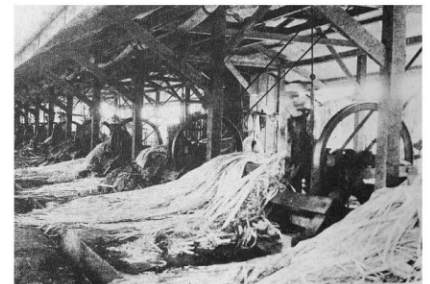
太田興業の麻ひき工場。動力ハゴタンを使い大量のアバカを繊維にした「フィリピンダバオ開拓写真集」(1940年発行)より(沖縄県ダバオ会提供)
