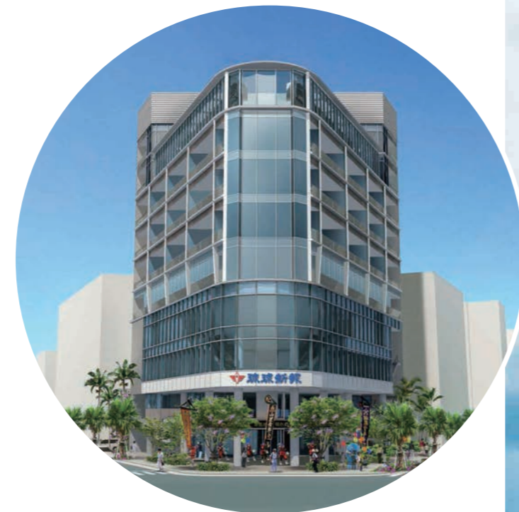
2018年春完成予定の琉球新報新本社ビル
